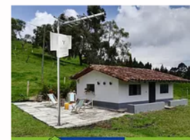
GRUPO ECHAVARRÍA RÚA 1000 IN PUBLICIDAD Y SEGURIDAD INSTALACIÓN en Poste Exterior con antena Yagi
